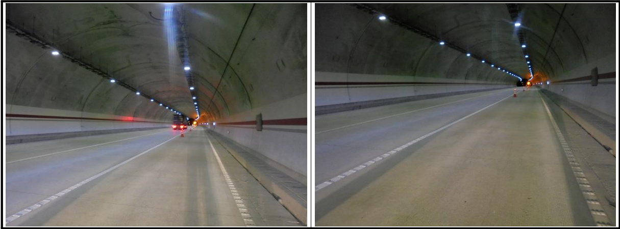
【사진 2.3.23】 포장부 전경
