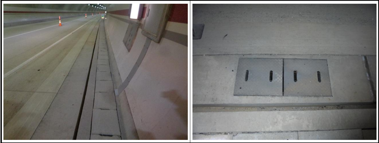
【사진 1.3.8】 공동구 및 배수시설 전경
