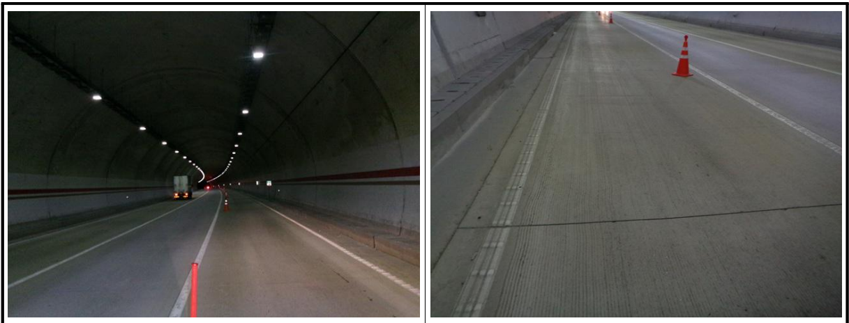
【사진 3.3.10】 포장부 전경
