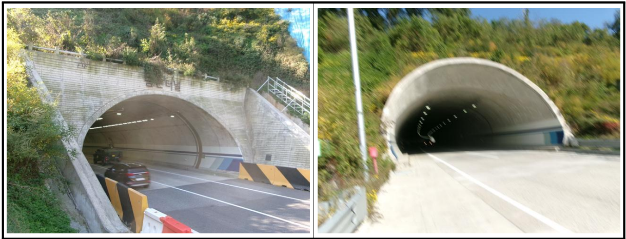
【사진 4.3.5】 갭문 전경
