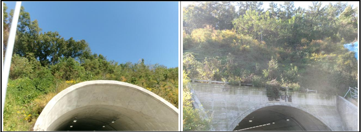
【사진 4.3.7】 사면 전경
