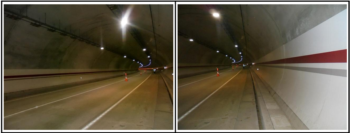
【사진 3.3.16】 라이닝 측벽부 전경
