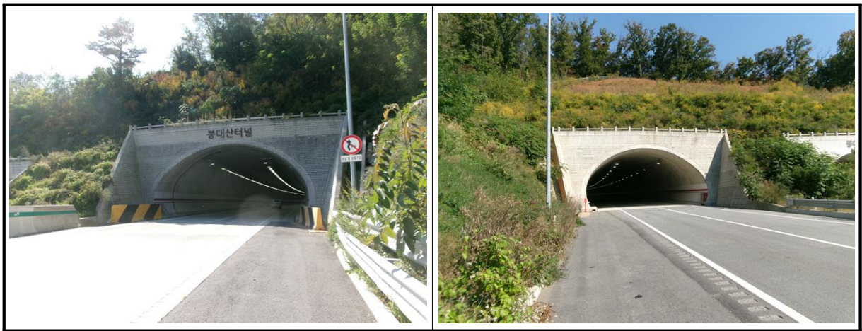
【사진 1.3.5】 갭문 전경
