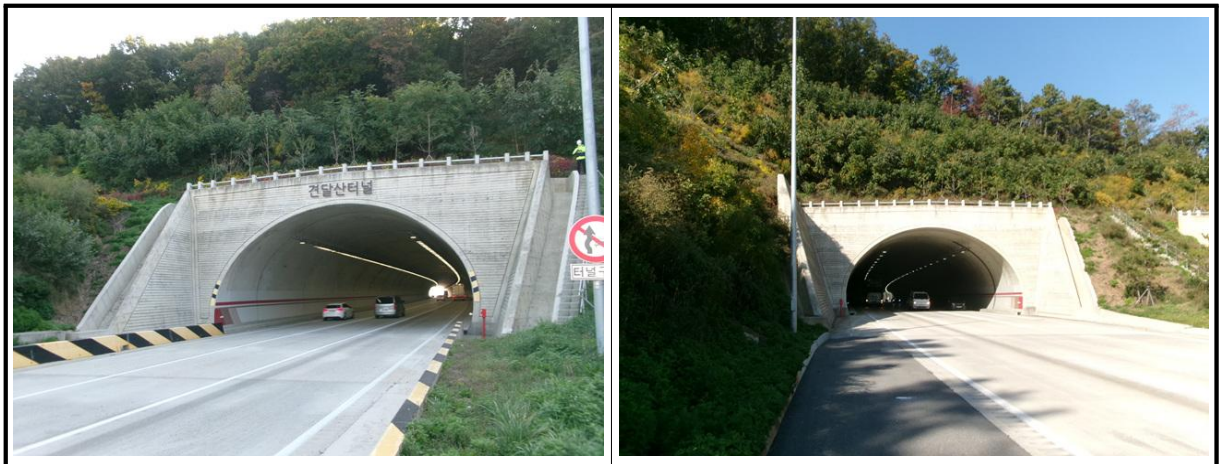
【사진 3.3.5】 갭문 전경
