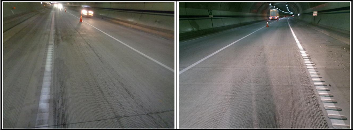
【사진 4.3.23】 포장부 전경
