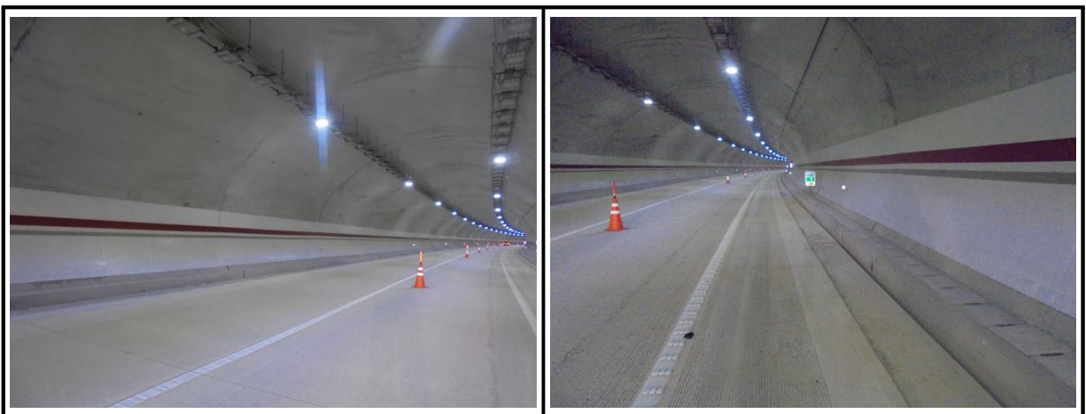
【사진 1.3.3】 라이닝 측벽부 전경
