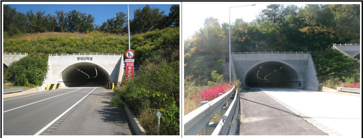
【사진 1.3.18】 갭문 전경
