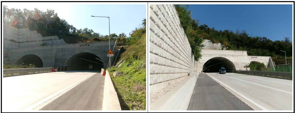
【사진 2.3.5】 갭문 전경
