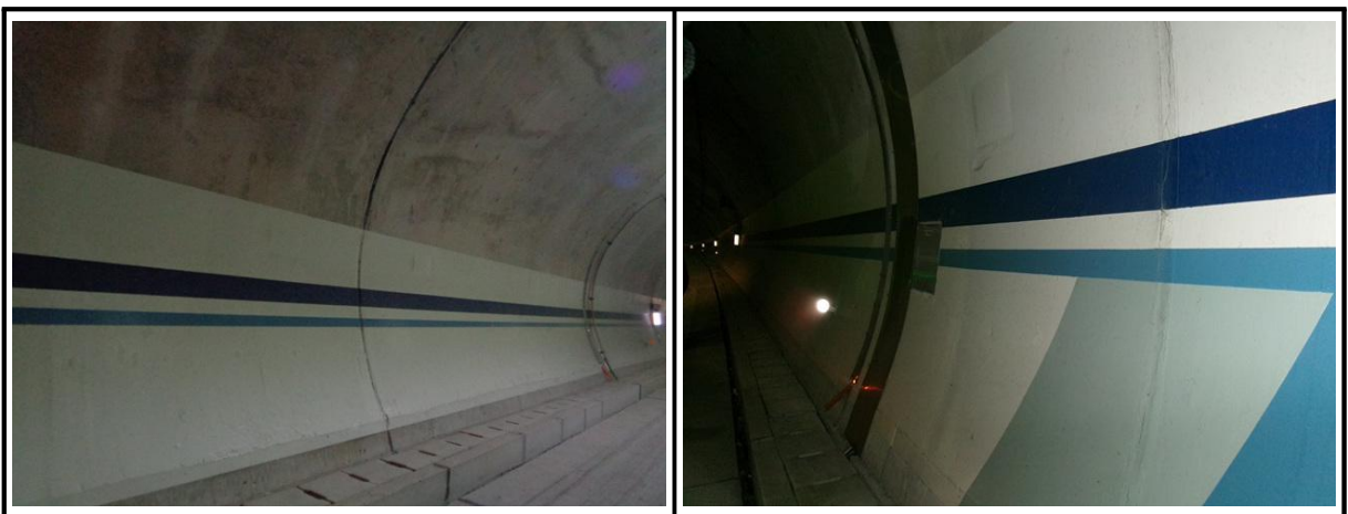
【사진 4.3.3】 라이닝 측벽부 전경
