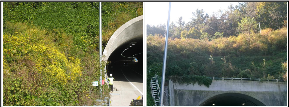
【사진 4.3.20】 사면 전경
