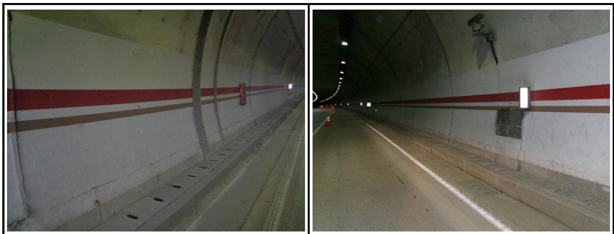
【사진 3.3.3】 라이닝 측벽부 전경
