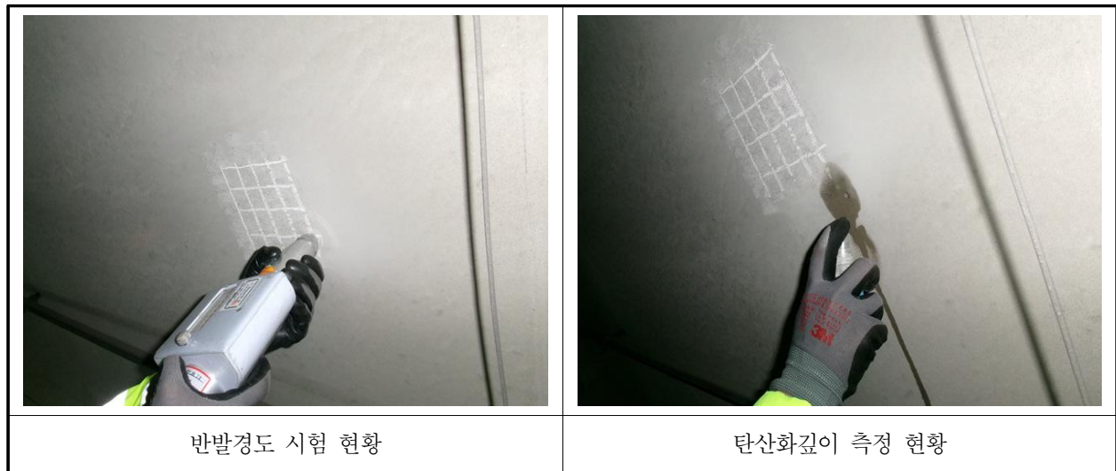
【사진 2.4.1】 콘크리트 내구성조사 현황
