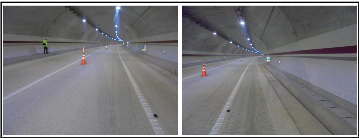
【사진 1.3.10】 포장부 전경
