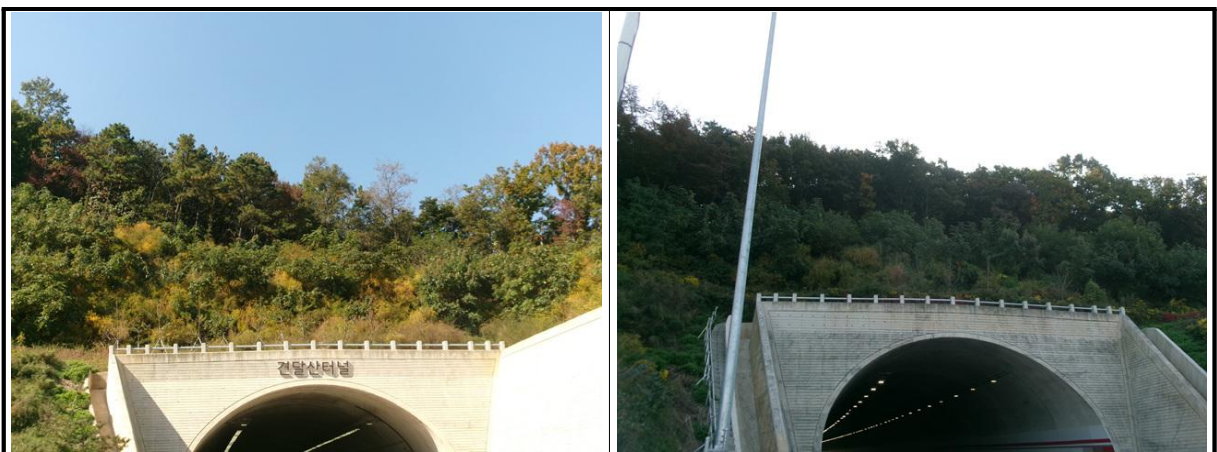
【사진 3.3.20】 사면 전경
