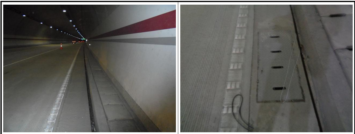
【사진 2.3.8】 공동구 및 배수시설 전경
