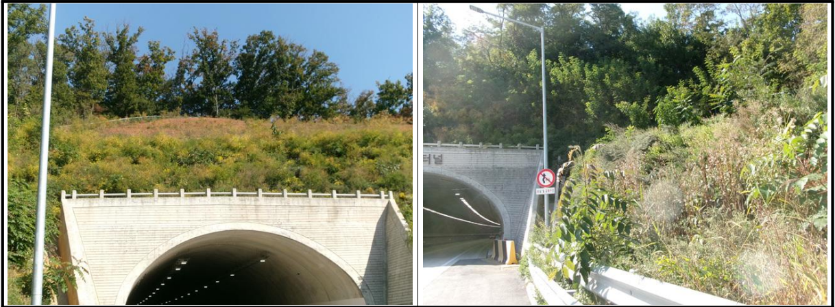
【사진 1.3.7】 사면 전경
