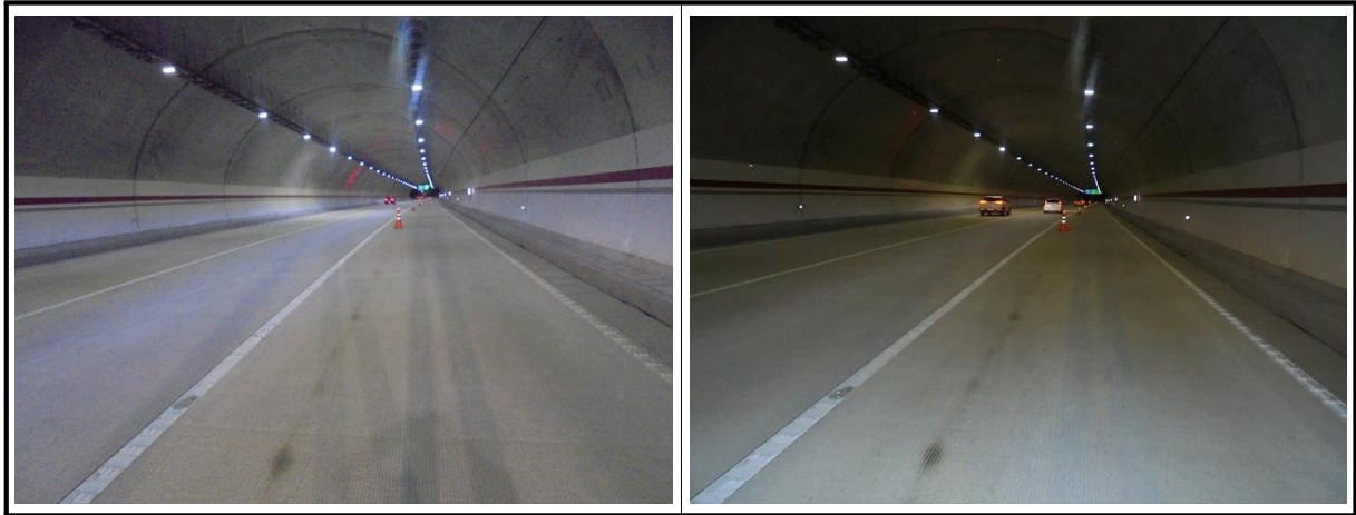
【사진 2.3.10】 포장부 전경
