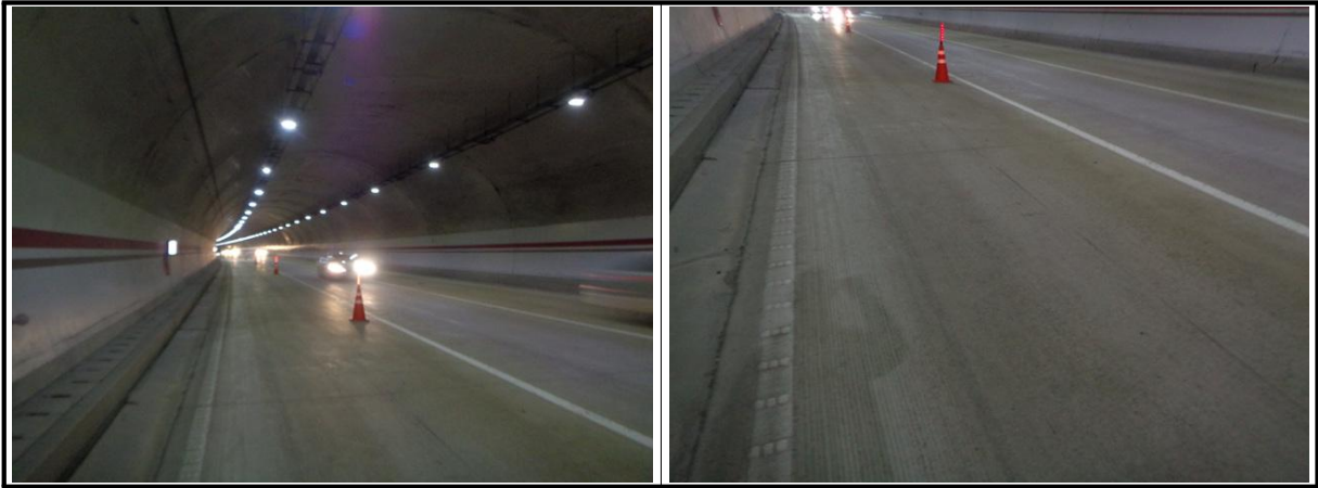
【사진 3.3.23】 포장부 전경
