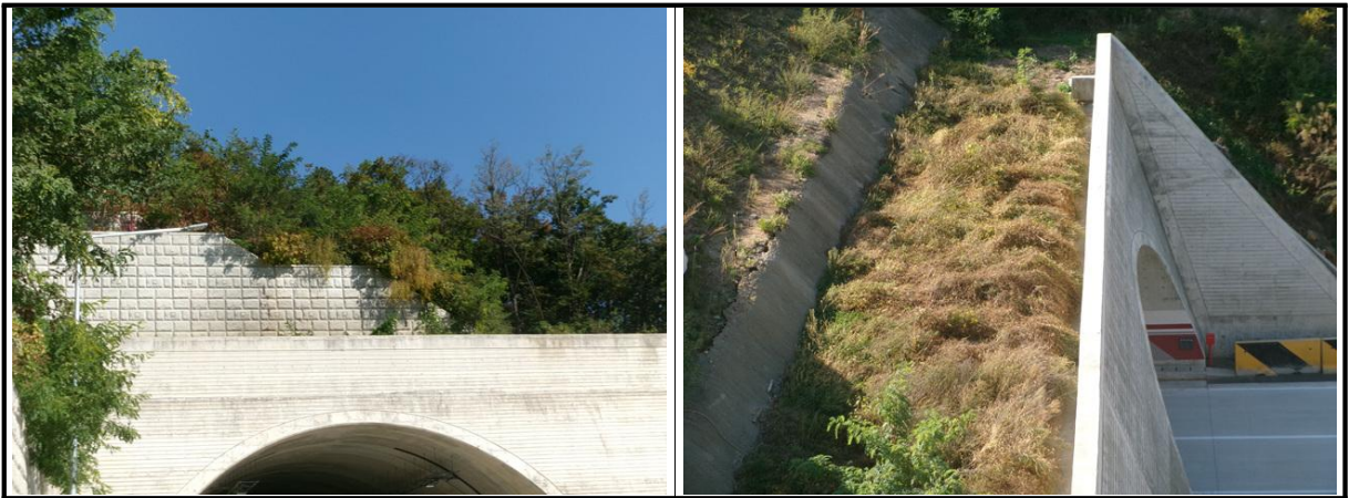
【사진 2.3.7】 사면 전경
