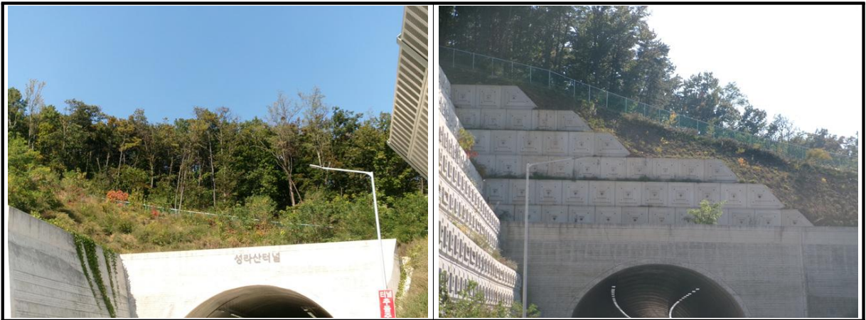
【사진 2.3.20】 사면 전경
