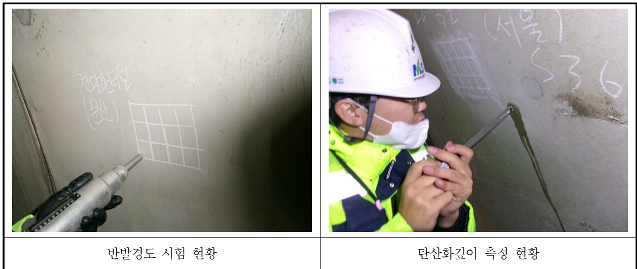
【사진 3.4.1】 콘크리트 내구성조사 현황
