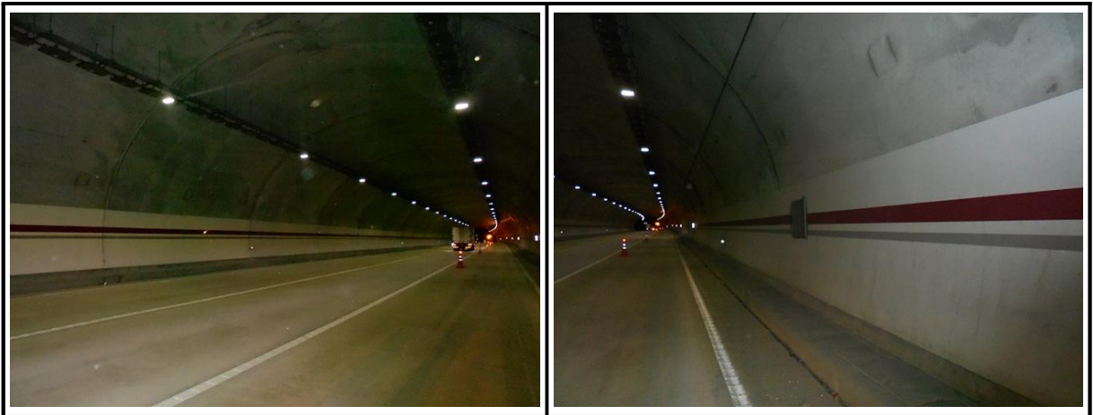
【사진 2.3.16】 라이닝 측벽부 전경
