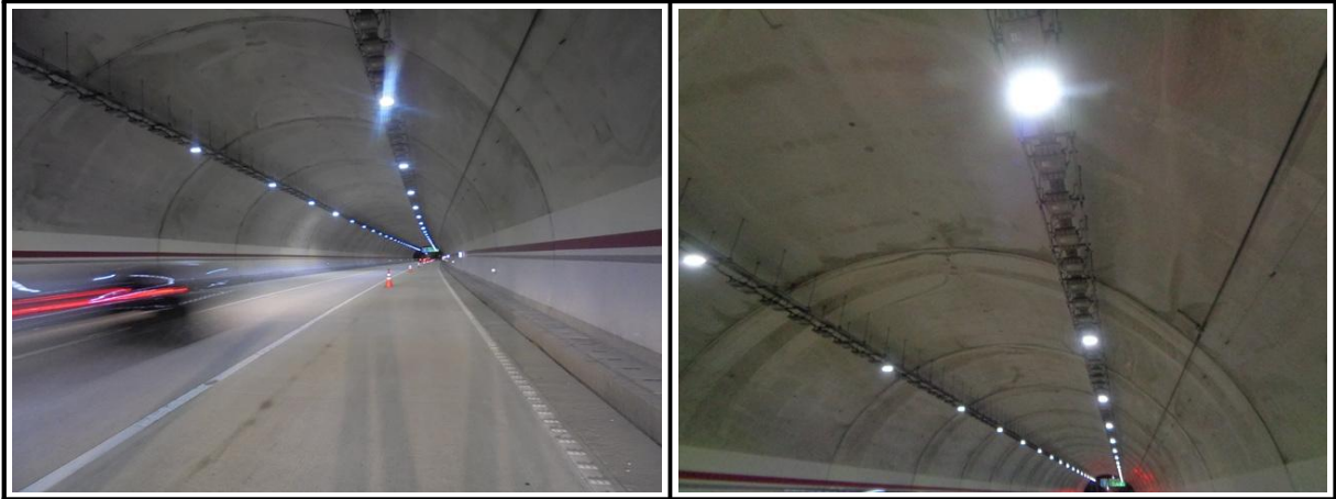
【사진 2.3.1】 라이닝 천단부 전경
