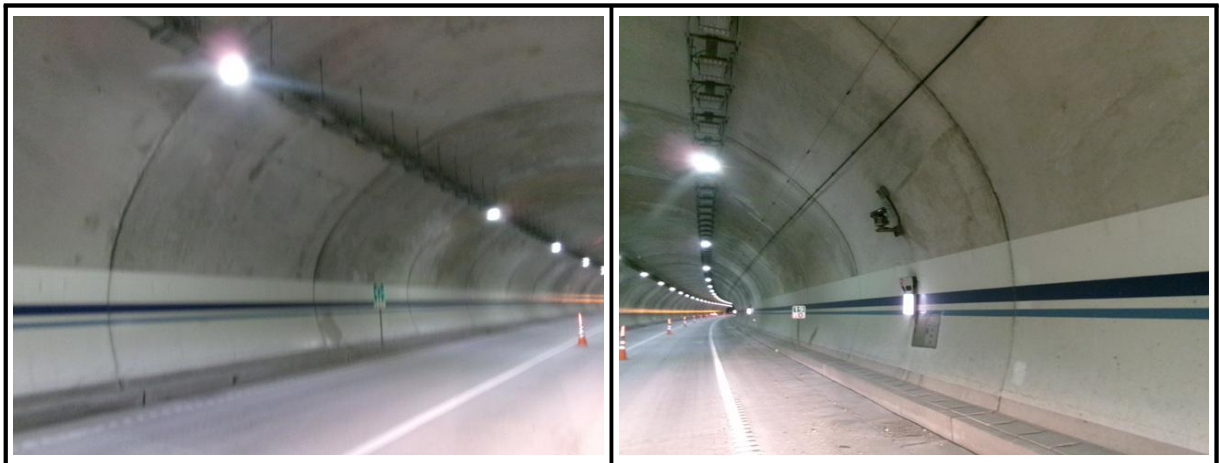
【사진 4.3.16】 라이닝 측벽부 전경
