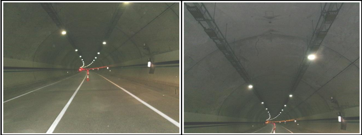
【사진 4.3.1】 라이닝 천단부 전경
