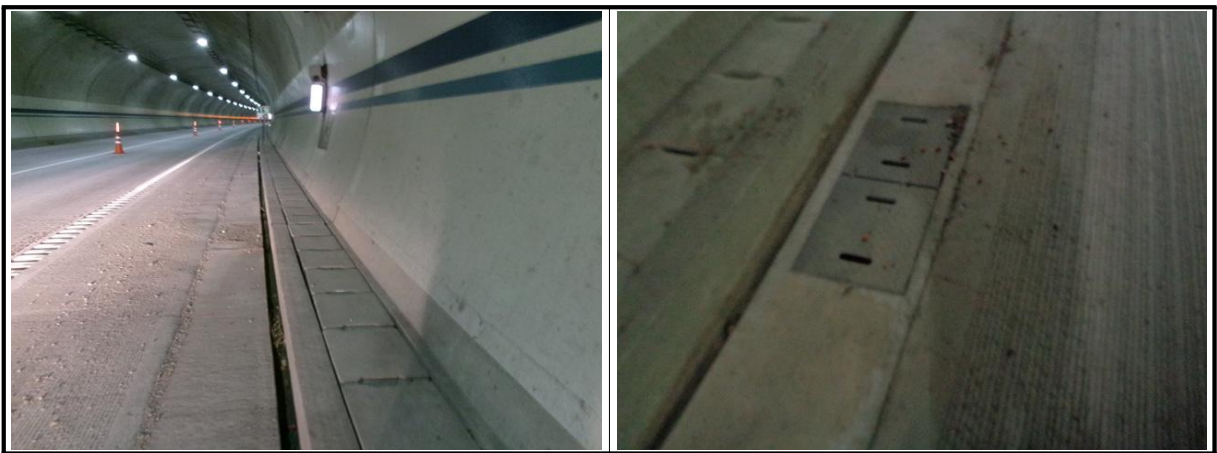
【사진 4.3.21】 공동구 및 배수시설 전경
