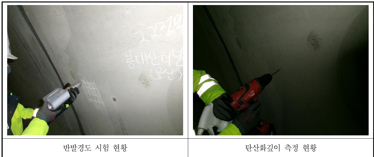
【사진 1.4.1】 콘크리트 내구성조사 현황
