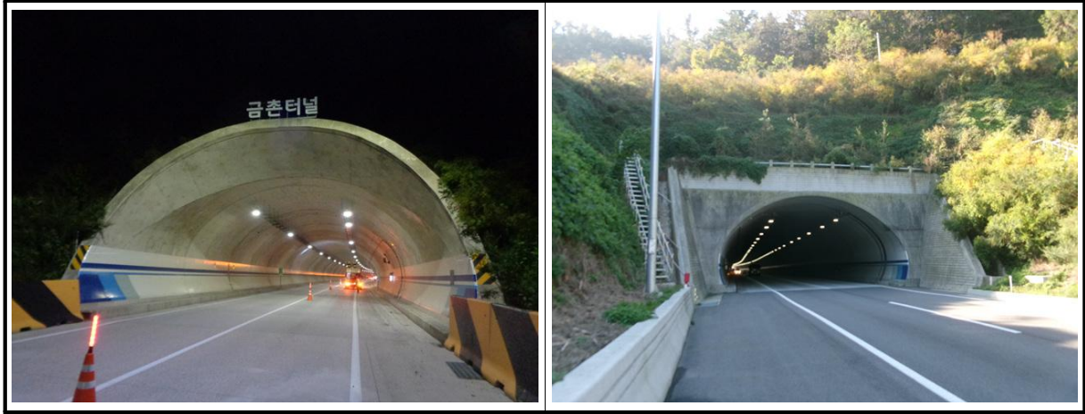
【사진 4.3.18】 갯문 전경
