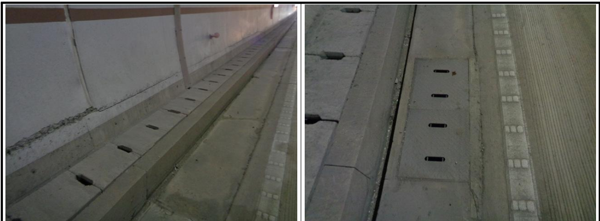
【사진 3.3.21】 공동구 및 배수시설 전경
