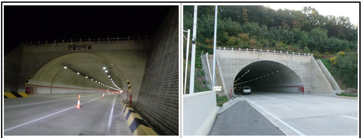
【사진 3.3.18】 갭문 전경
