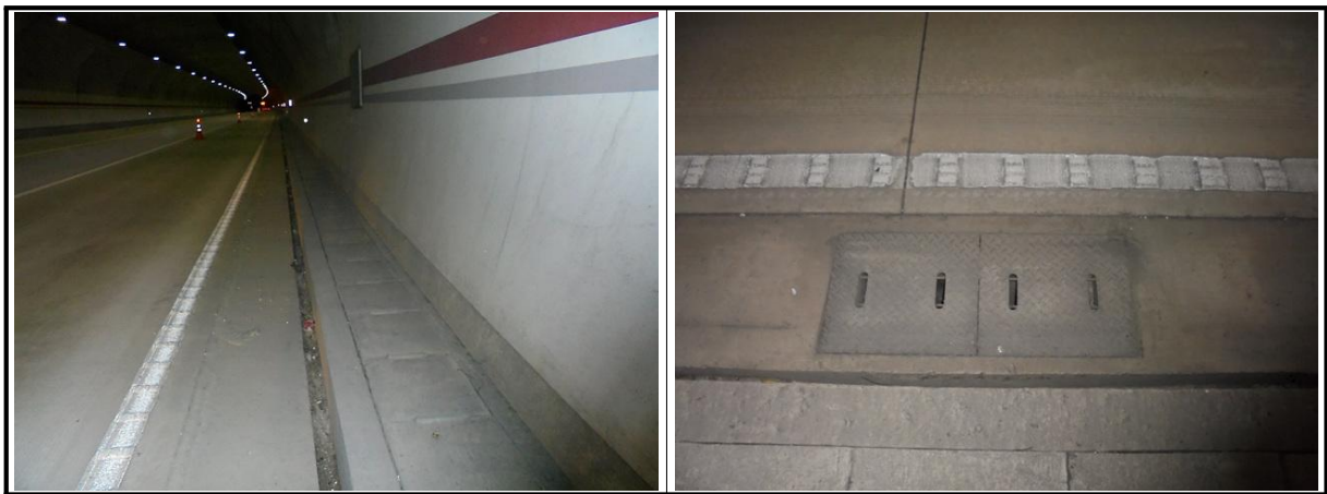
【사진 2.3.21】 공동구 및 배수시설 전경
